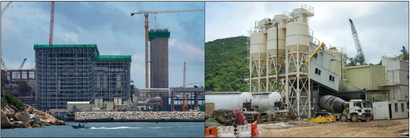
<홍콩 폐기물 에너지 소각시설 I-PARK 1 건설 현장>
