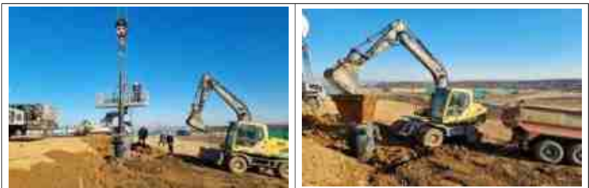
<유공관 연장 설치>
