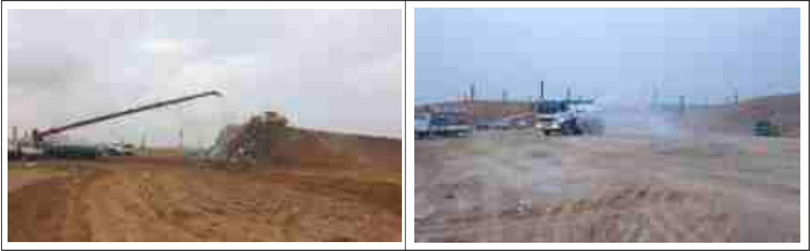
<내부도로 비산먼지 저감 및 살수>
