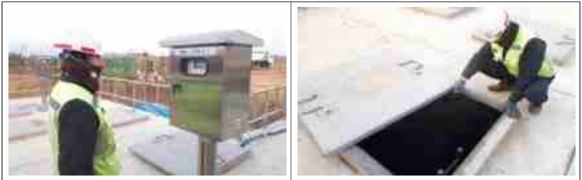
<각 펌프장 수위계 확인 및 저류조내부 확인>
