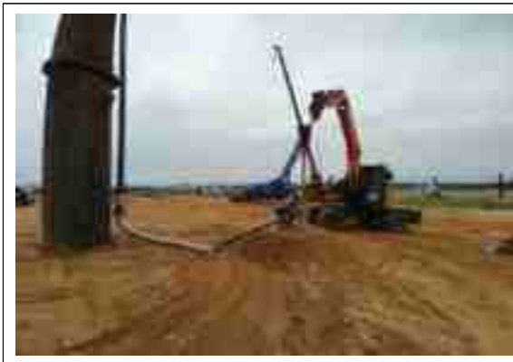
<토사 퇴메우기 및 다이크 설치>
