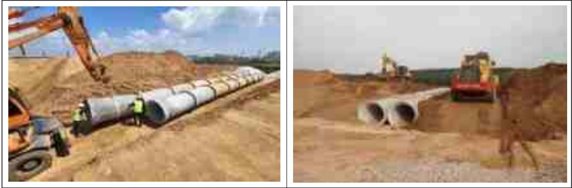
<횡단관 부설 및 되메우기>
