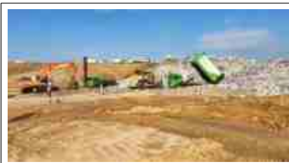
<폐기물 차량 간 안전거리 (10m 이상) 확보>
