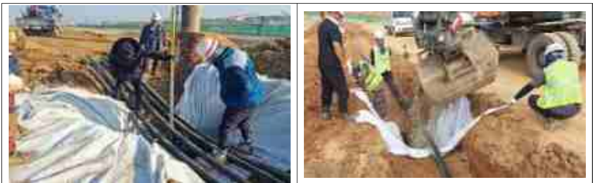
<응축수 배수장치 부직포 설치 및 골재 포설>
