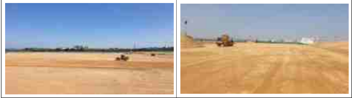
<중간복토 작업 및 복토면 다짐>
