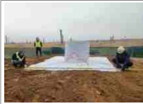
<차수매트 차단공 설치>
