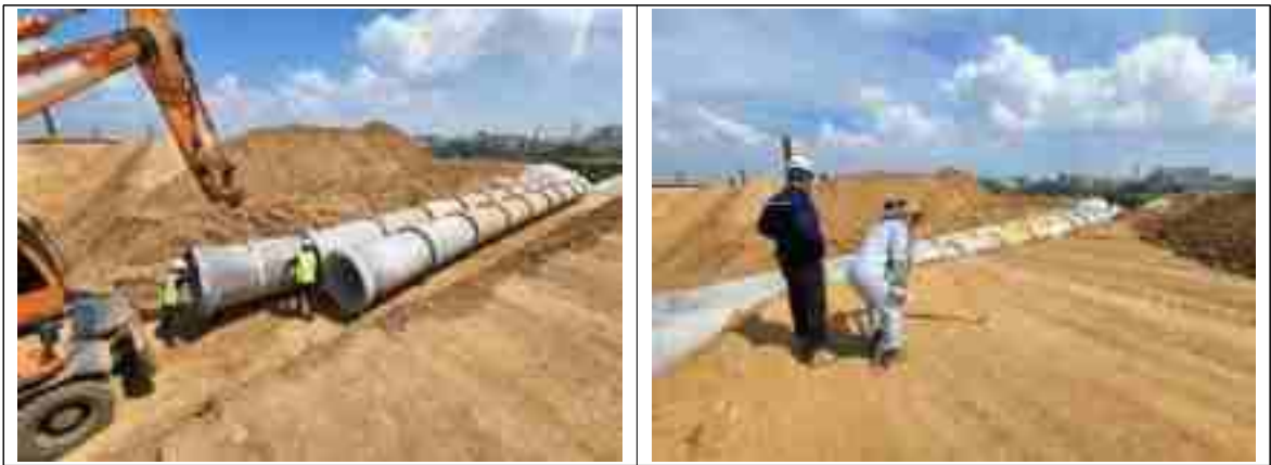
<제방 횡배수관 설치>
