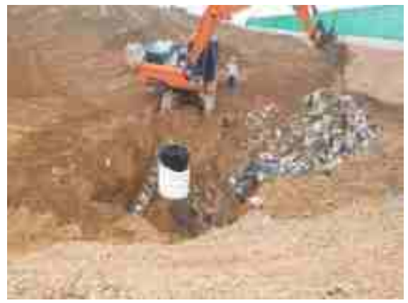
<수직배제정 주변 터파기>
