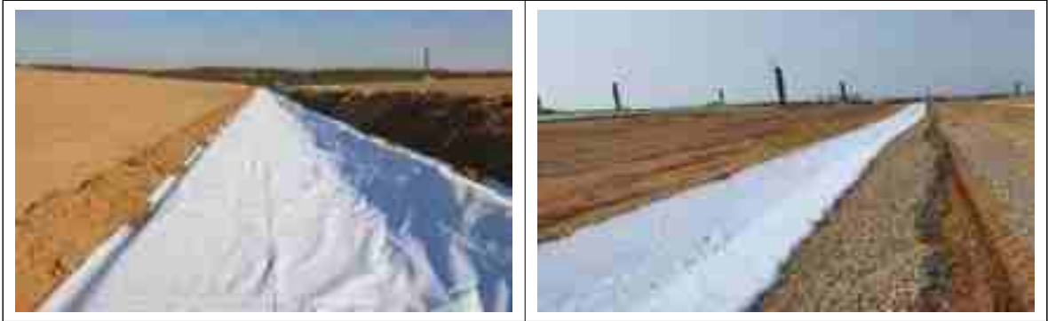
<토사측구 상부 차수매트 설치>
