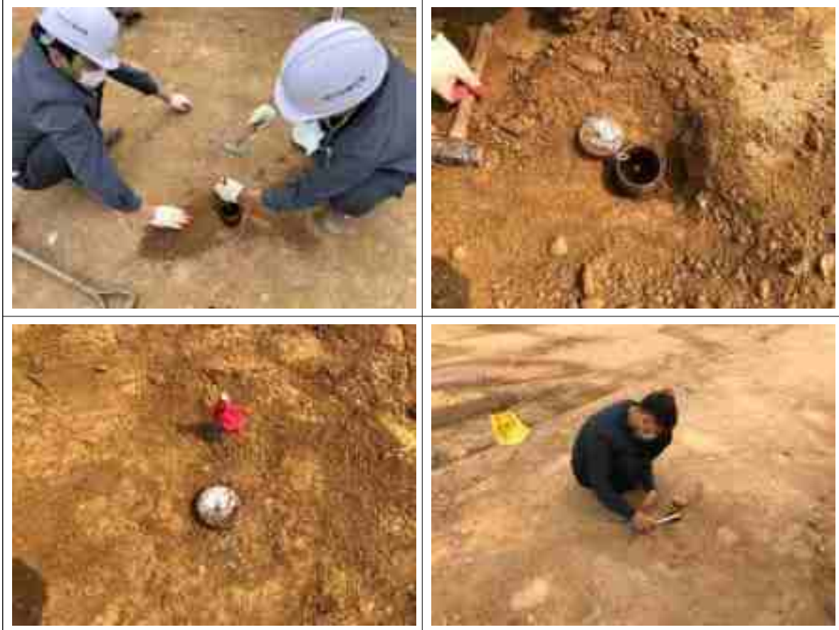
<제방측방 변위계 설치과정>
