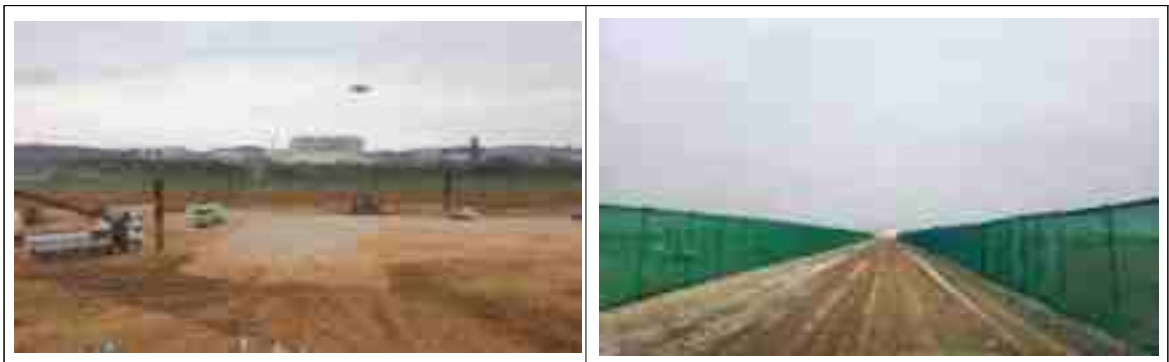
<보조운행로 및 비산방지망 설치>
