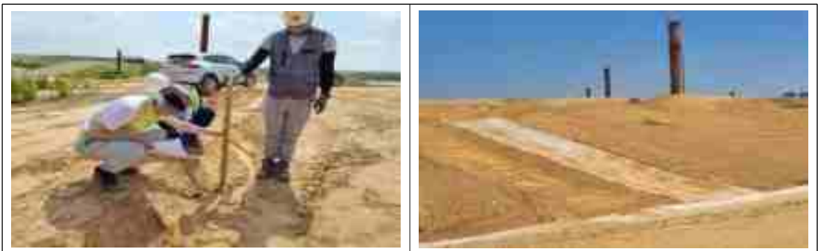
<토사측구 상부 차수매트 설치>
