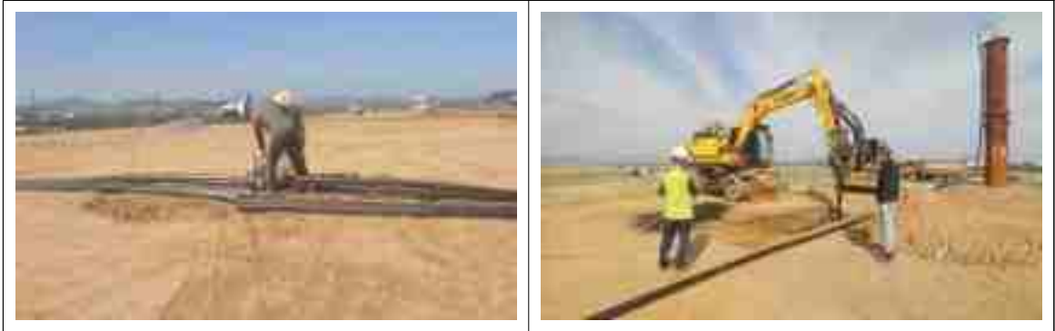
<이송관로 부설 및 응축수 배수장치 천공>
