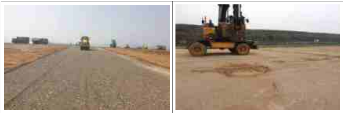
<복토면 유지관리도로 및 균열부 보수>
