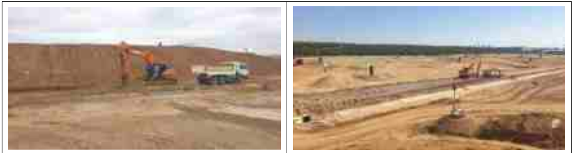
<내부도로 절취 작업>
